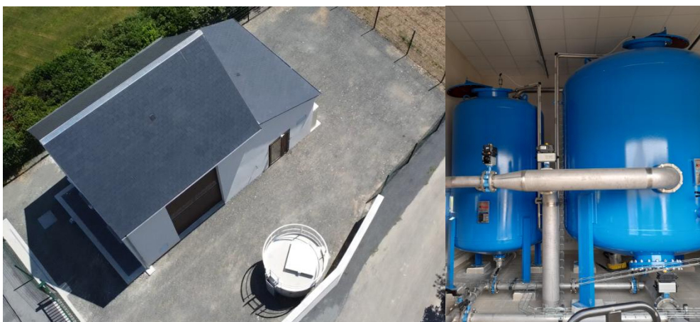
Les Grandes Vignes – TAUXIGNY – station traitement du fer
