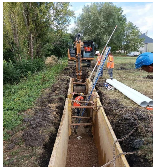
Dévoisement de conduite à Manthelan
