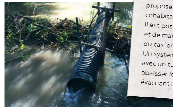
POSE DE SIPHON
